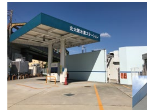
水素ステーション
