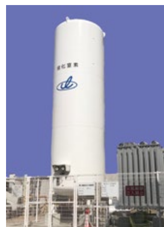
超低温液化ガス製造施設(CE)
